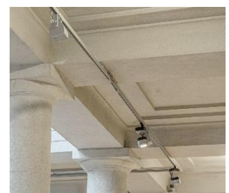
Lautsprecher an Lichtschienensystem
