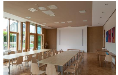
Projektionsfläche und Lautsprecherzeilen im Saal
